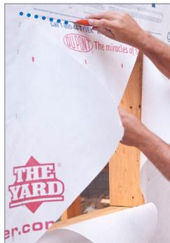
Corte la sección del encabezado al ras con la parte superior de la abertura sin terminar y deséchela.
