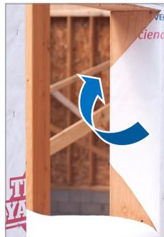
Envuelva ambas secciones de la jamba en la abertura sin terminar de la ventana y asegúrelas firmemente con grapas.
