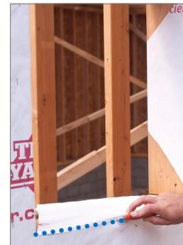
Corte la sección del alféizar al ras con la parte inferior de la abertura sin terminar y deséchela.
