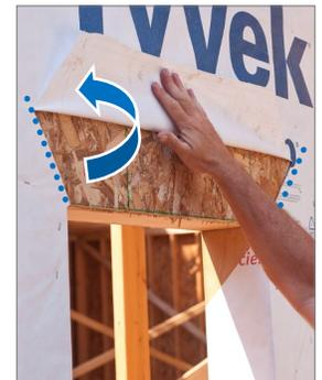
Haga dos cortes de 45° en la sección del cabezal y dóblelos y sujételos con grapas o membrana.
