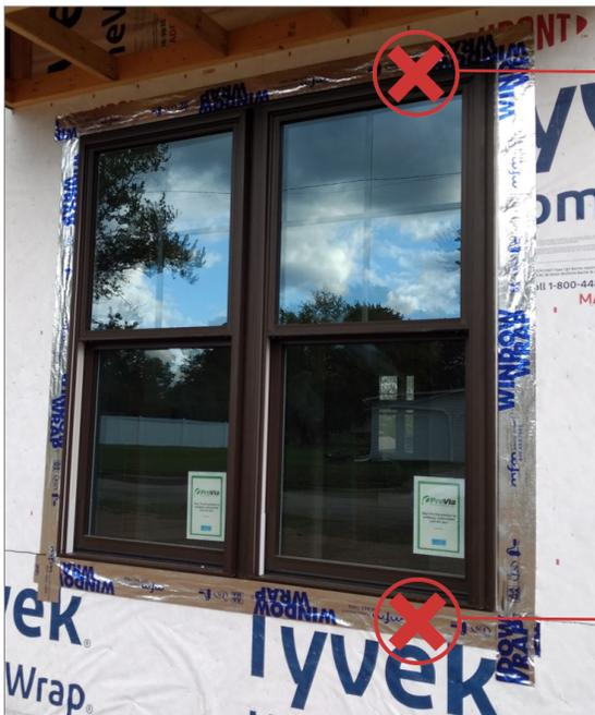
**La envoltura de casa se colocó en el interior de la estructura. Si el agua penetra por detrás de la envoltura de casa, puede canalizarse directamente hacia el interior de la estructura.**
